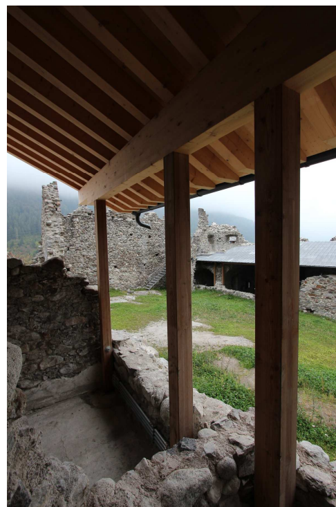
5. Particolare della copertura del corpo adiacente il mastio
