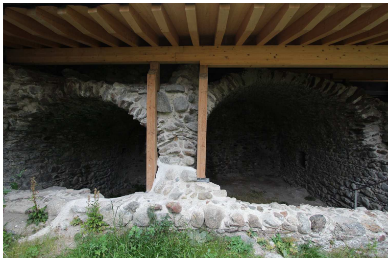
4. Particolare della copertura del corpo
