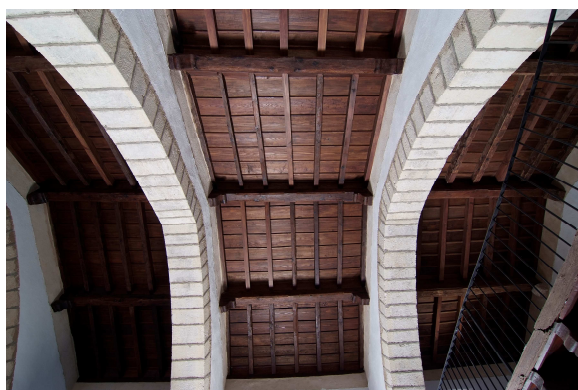
2. Copertura lignea della chiesa di Benifassá dopo il restauro
