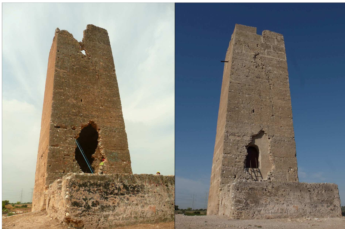
1. La torre Bofilla prima e dopo l'intervento
