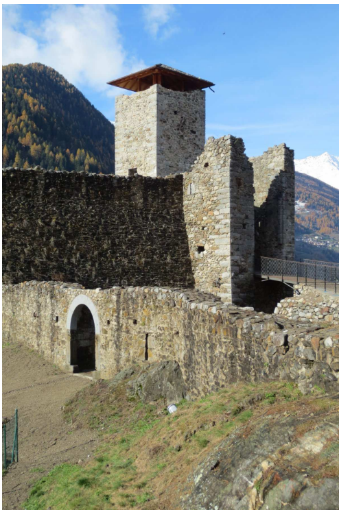
2. Particolare della copertura del "torrino"
