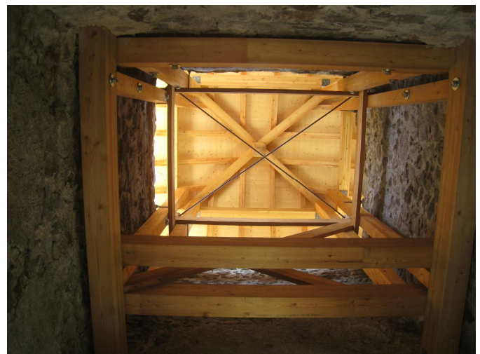
3. interno del "torrino"
