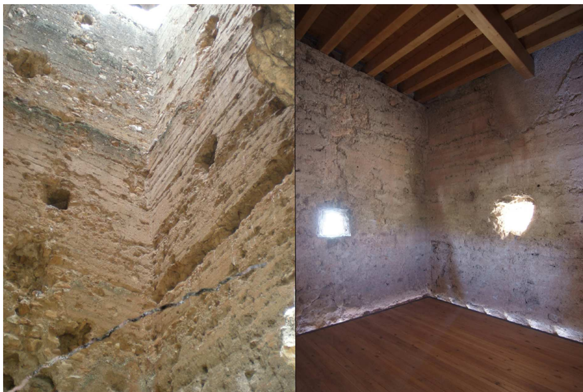
2. L'interno della Torre Bofilla prima e dopo l'intervento
