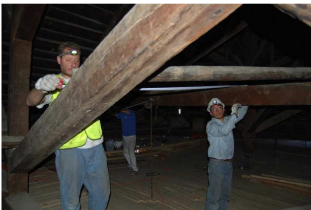
2. Valutazione della difettosità e classificazione strutturale su una struttura di legno in opera.
