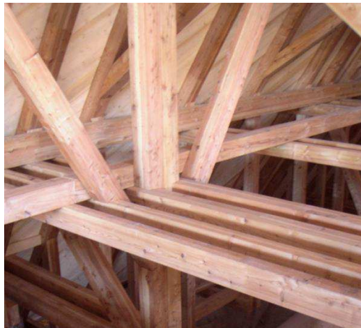
4. La copertura lignea ricostruita della "Pieve" in Cavalese e particolare di un nodo del telaio di sostegno longitudinale
